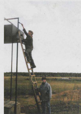
Korrosioonikindel värv metallkarkassile.
